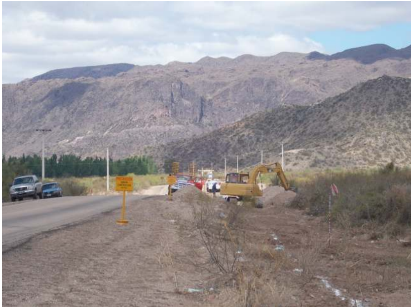
Foto 120 - Construcción de red cloacal para Valle Grande. Fuente: Archivo fotográfico de Natalia Pucciarelli, 2010.
