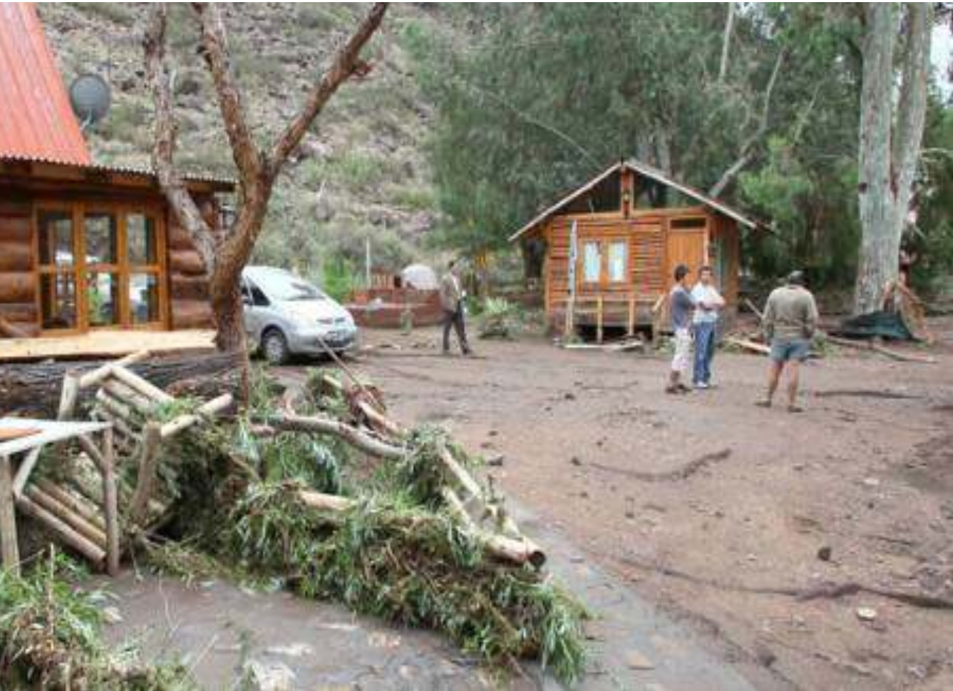
Foto 114 - Daños producidos por la tormenta del 17/12/2009 en Valle Grande. www.diariouno.com.ar
