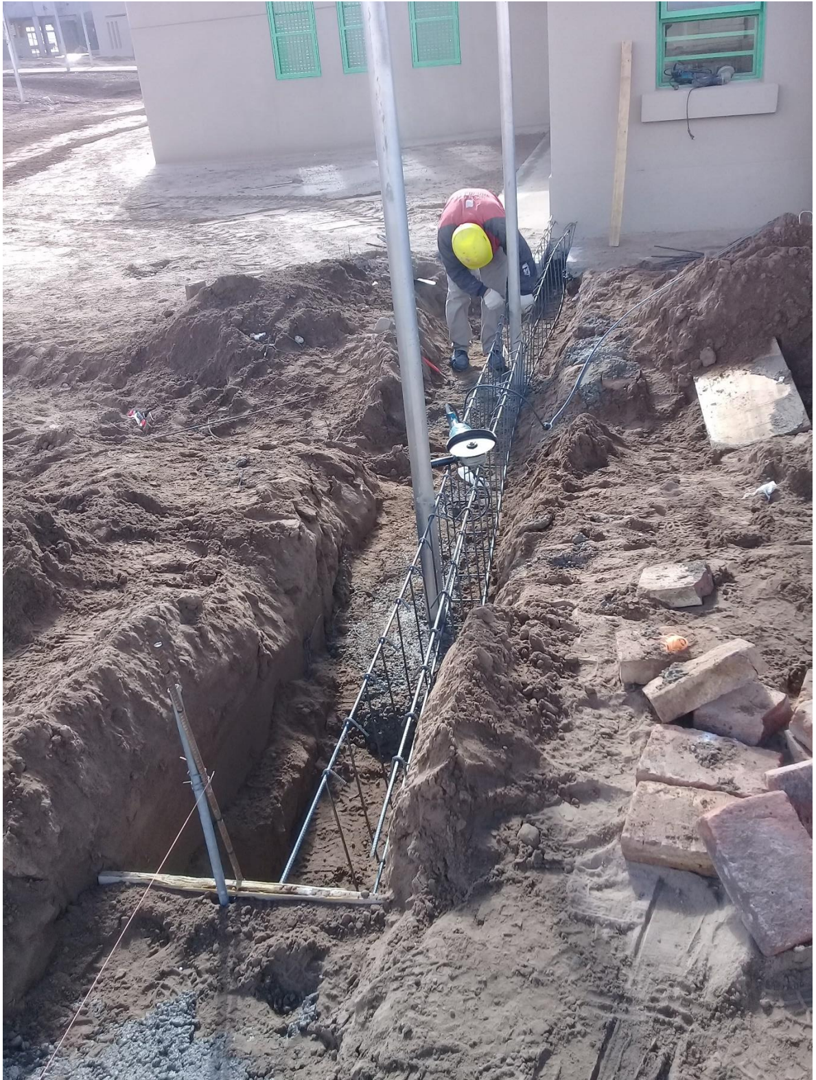
Ilustración 20 Armado y colocación de viga de vinculación del cierre
