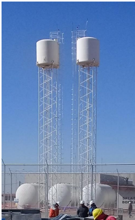
Ilustración 7 Almacenamiento de agua potable
