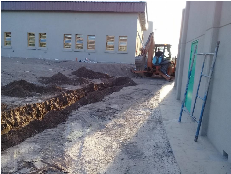
Ilustración 24 Excavación de acequia captadora de las aguas que escurren desde el predio.
