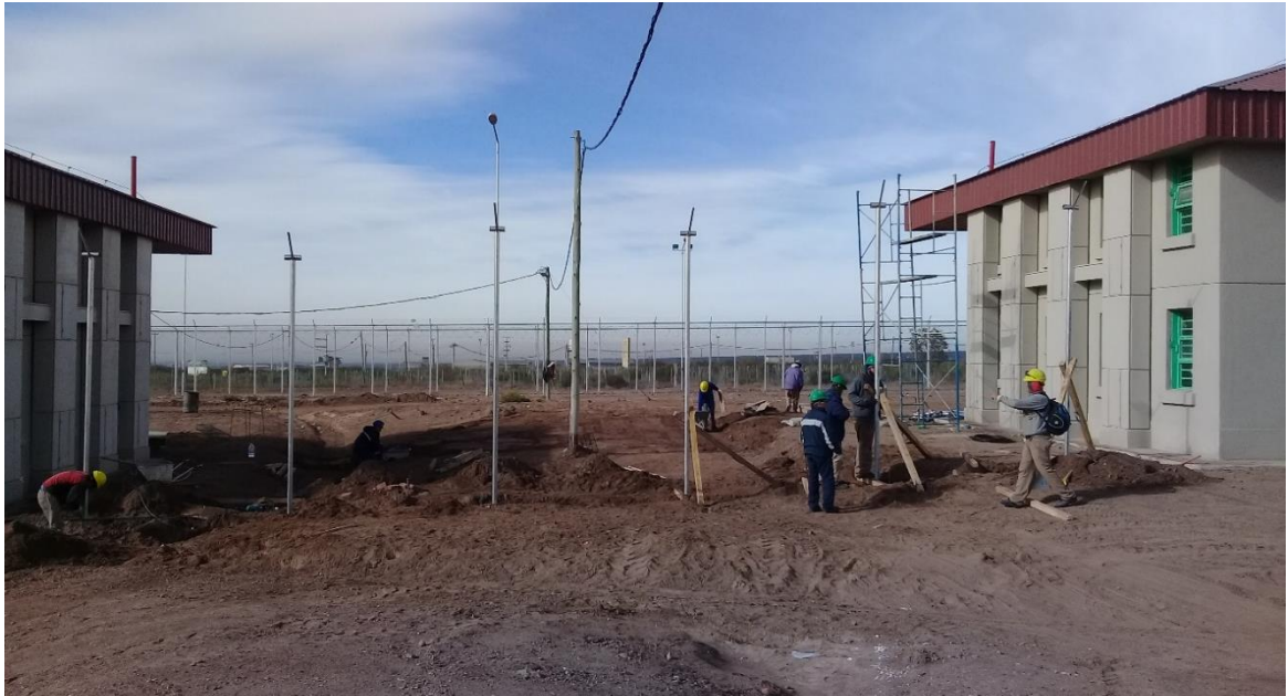
Ilustración 21 Cierre entre pabellones AP3 y AP2, de aproximadamente 20 m de largo y 4 m de altura
