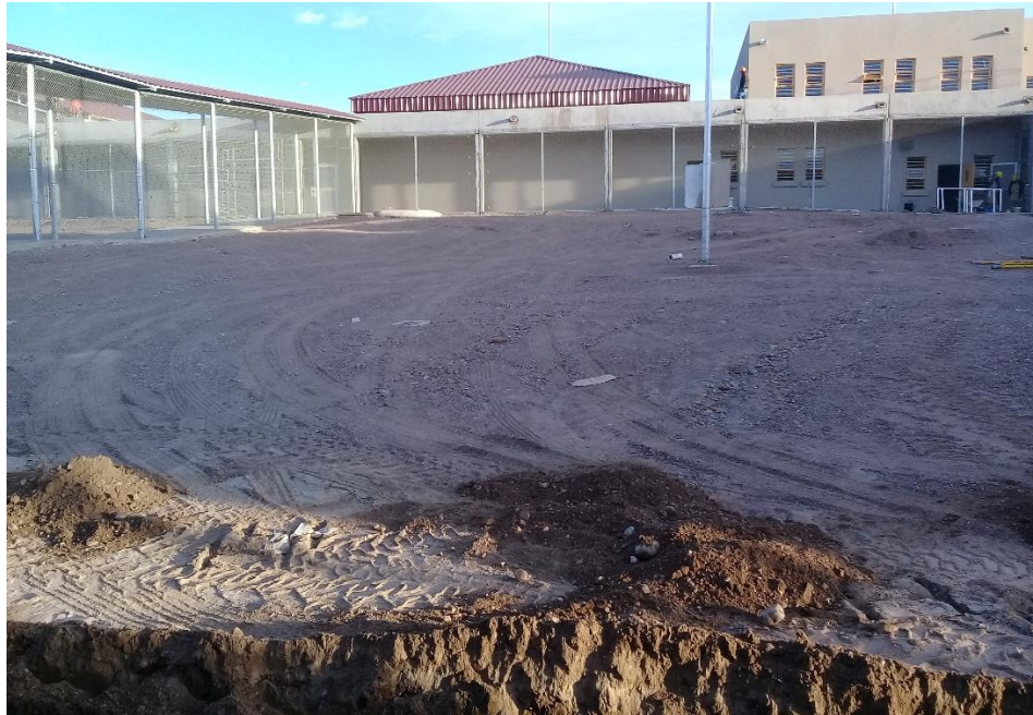
Ilustración 23 Limpieza del predio antes de realizar el cierre.
