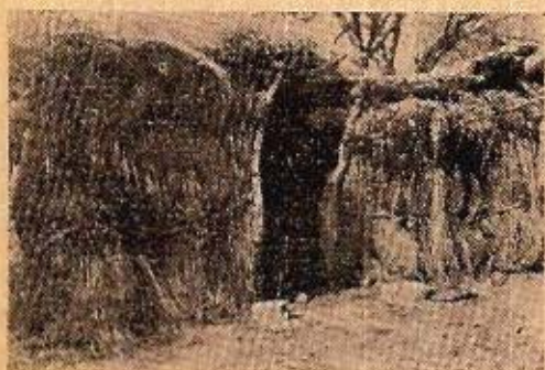
Fig. 6. Vivienda temporaria hecha con Sporobolus rigens . Armadura de algarrobo. Capilla del Rosario - Guanacache - Lavalle.
