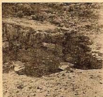
Fig. 1. Vivienda excavada en la pendiente de un cerro. Techo de cortadera y tierra. Mechanquil - Dpto. de Malargüe. (Foto A. Ruiz Leal)
