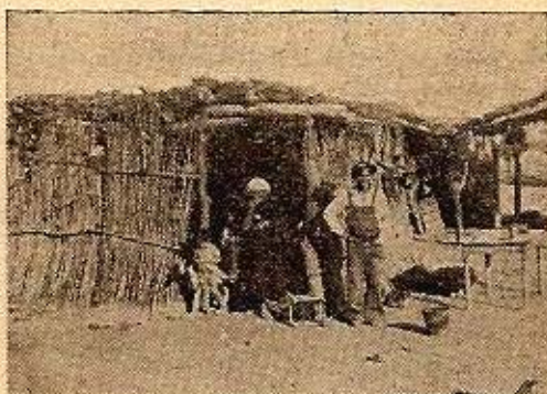
Fig. 2. Rancho de junquillo, con armadura de algarrobo y álamo. Las Hormigas - Guanacache - Lavalle
