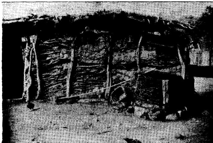
Fig. 2. - Pared de un rancho construida con barro, pasto coirón y palos de algarrobo. En primer plano, una "pirhua" bajada de su soporte. (Usno - Valle Fértil).
