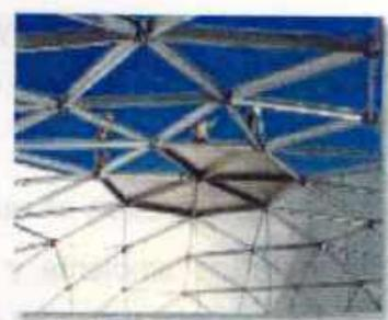
Tanques nuevos: Especificados como tanques de techo flotante, pueden ser diseñados usando un techo fijo (Domo de aluminio o cónico de acero) en conjunto con una CIF.
