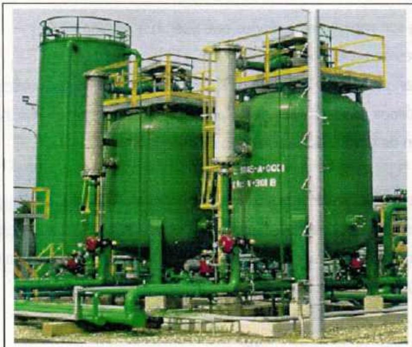
El lecho filtrante está compuesto por 80% de cáscara de nuez molida AP-51 y 20% de cáscara de avellana molida AX-12 colocadas sobre una malla 12-20.
