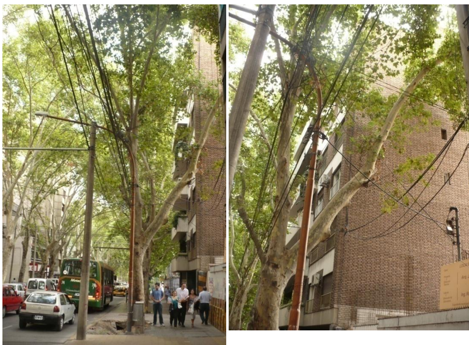
Fotos Nº 3 y 4. Calle y vereda medianamente amplios en una cuadra de España (izq.); roces entre la copa y el cableado aéreo (der.)
